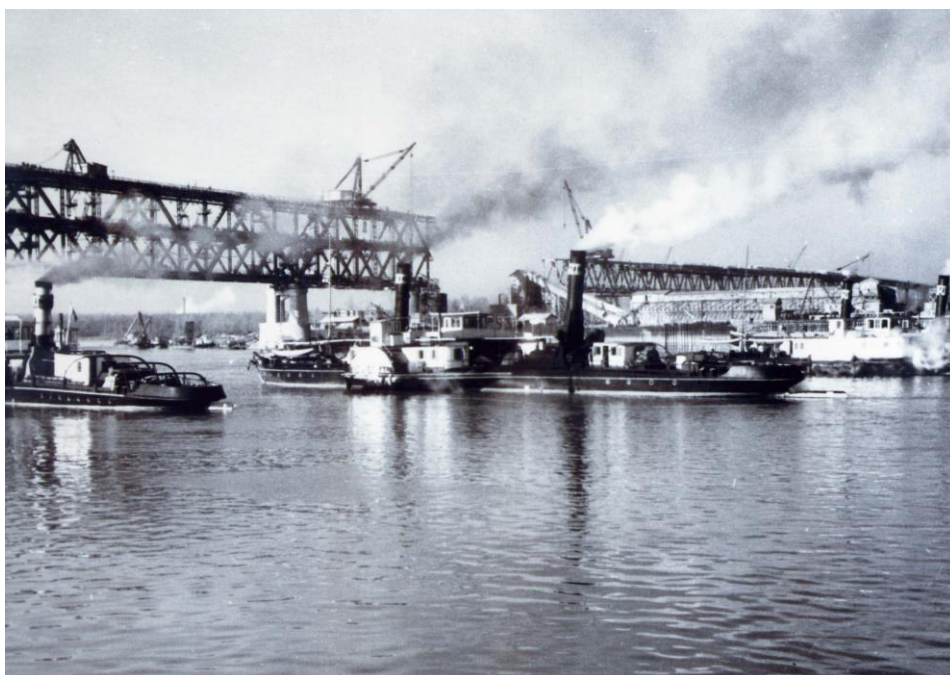
Строителството на моста, 1953 г.
